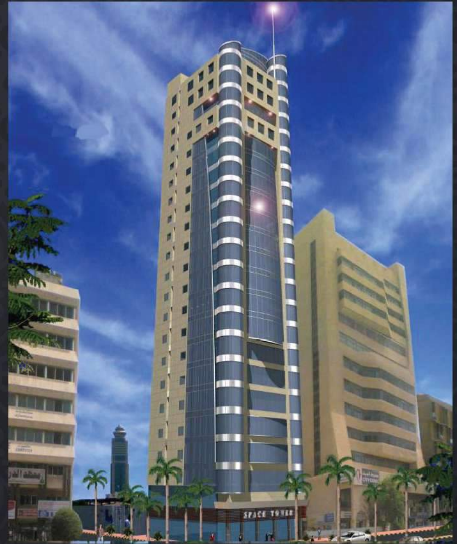
برج تجاري بمنطقة المرقاب . ملك شركة الشاهد العقارية يتكون من : أرضي + ميزانين + ٢٠ متكرر + خدمات
